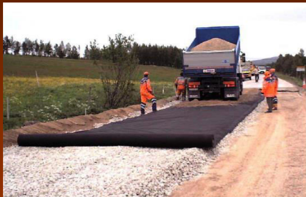
Отсыпка основания дорожного полотна
